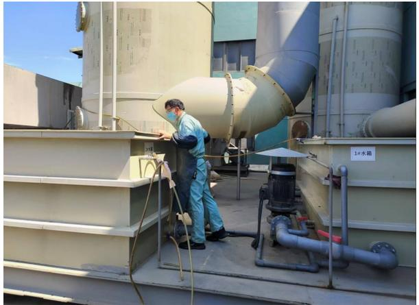
纺丝油烟水喷淋冷却装置
